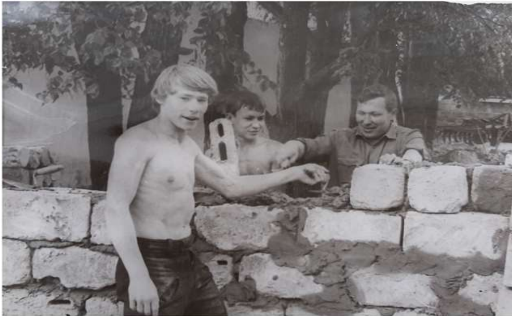
Строительство гаража для с-х техники
