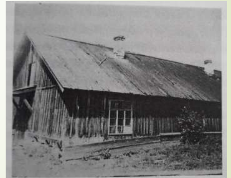
Первое здание начальной школы на центральном участке п/з «Пионер»
