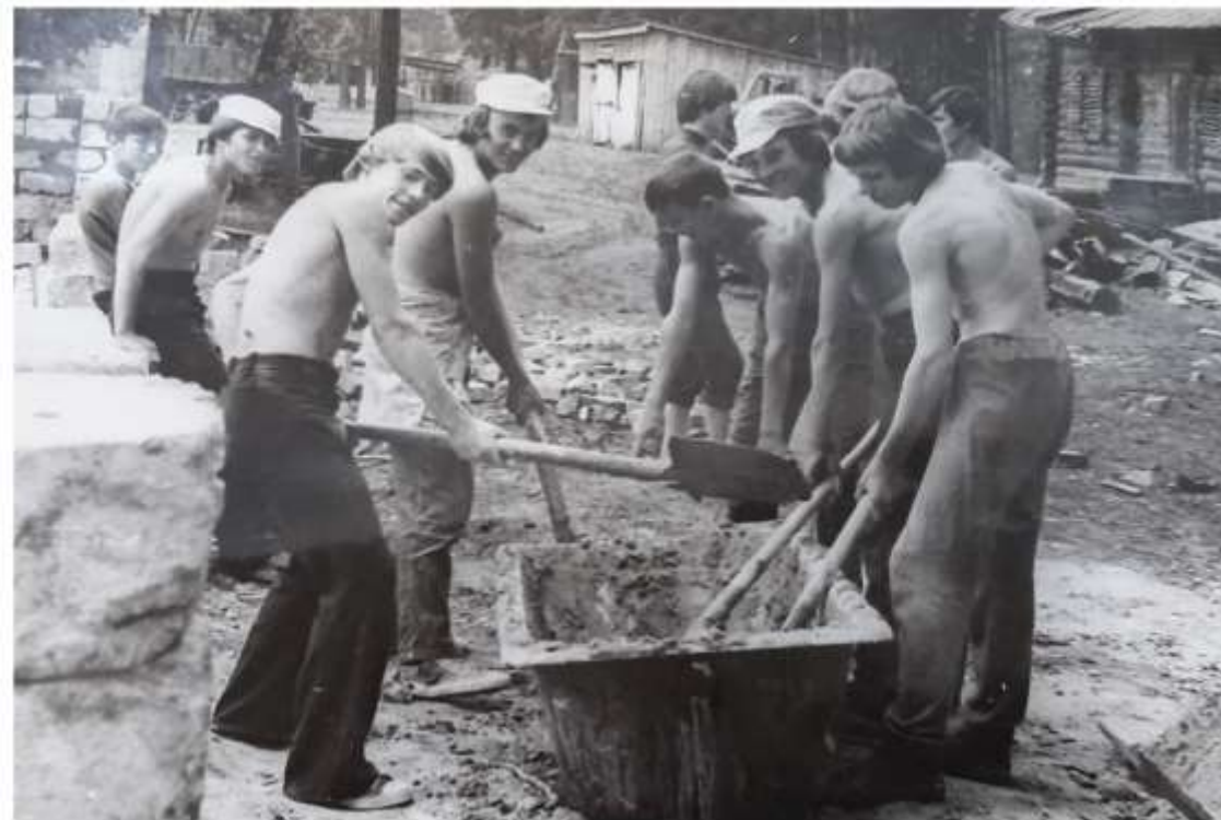
Строительство склада для сельхозтехники.
